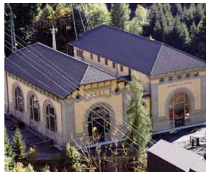
La centrale idroelettrica di Carona
