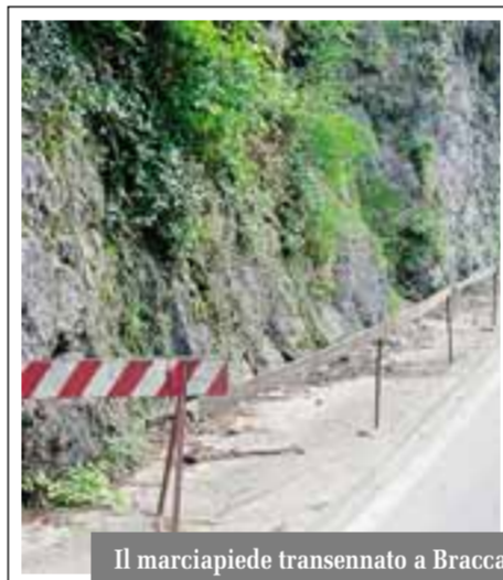
Il marciapiede transennato a Bracca
