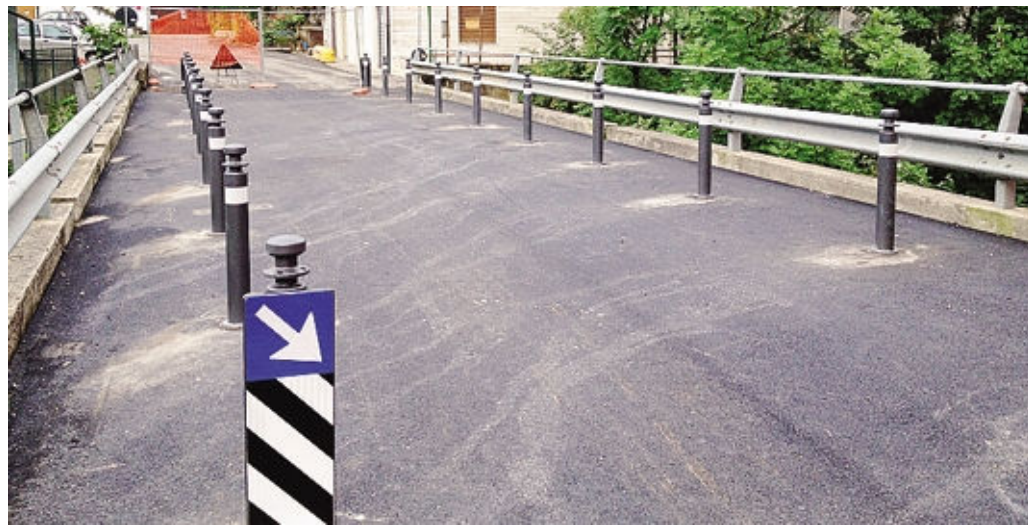
Il vecchio ponte della strada Priula è stato «rinforzato» e riaperto: si circola a senso alternato
