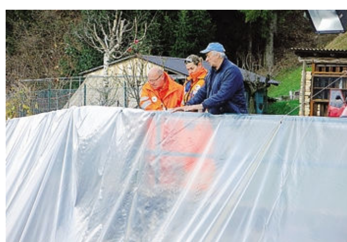
I teli posati a protezione della frana a Valzella di Gromo FOTO FRONZI
